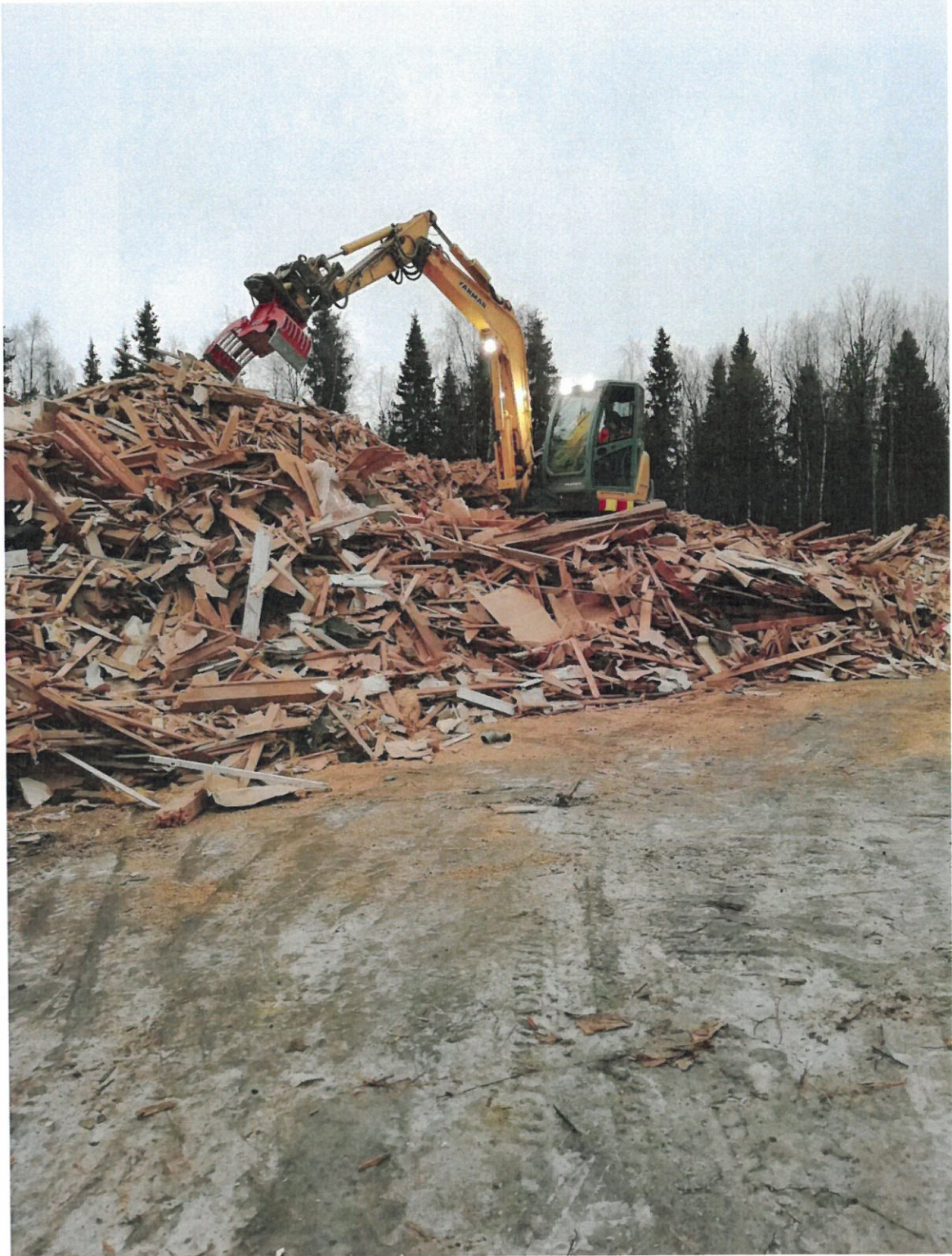
Kuva 6. Purkujätettä, joka on kuljetettu murskattavaksi kiinteistölle ROSKALA (583-402-27-5).
