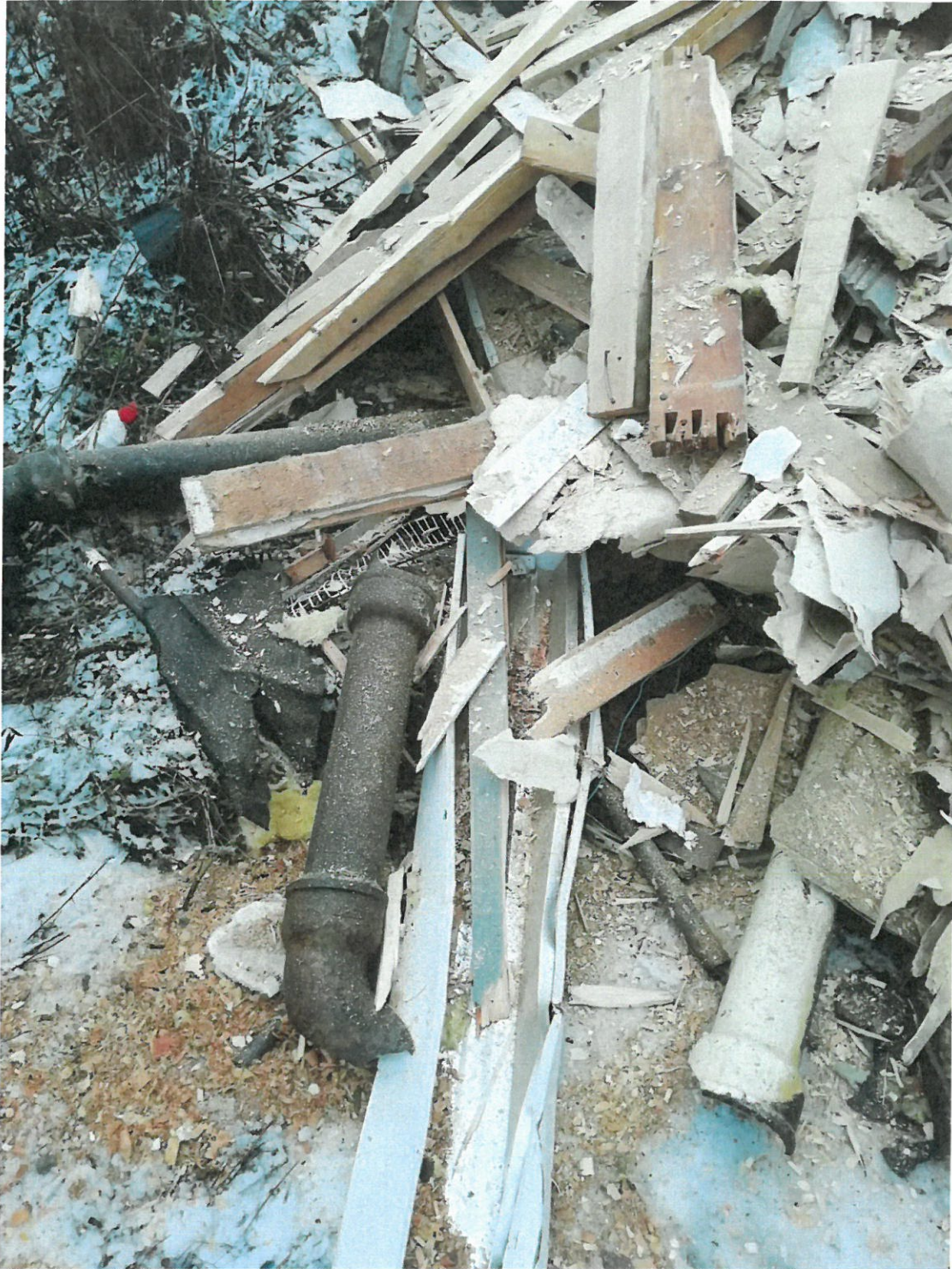
Kuva7. Purkujätettä, joka on kuljetettu murskattavaksi kiinteistölle ROSKALA (583-402-27-5).
