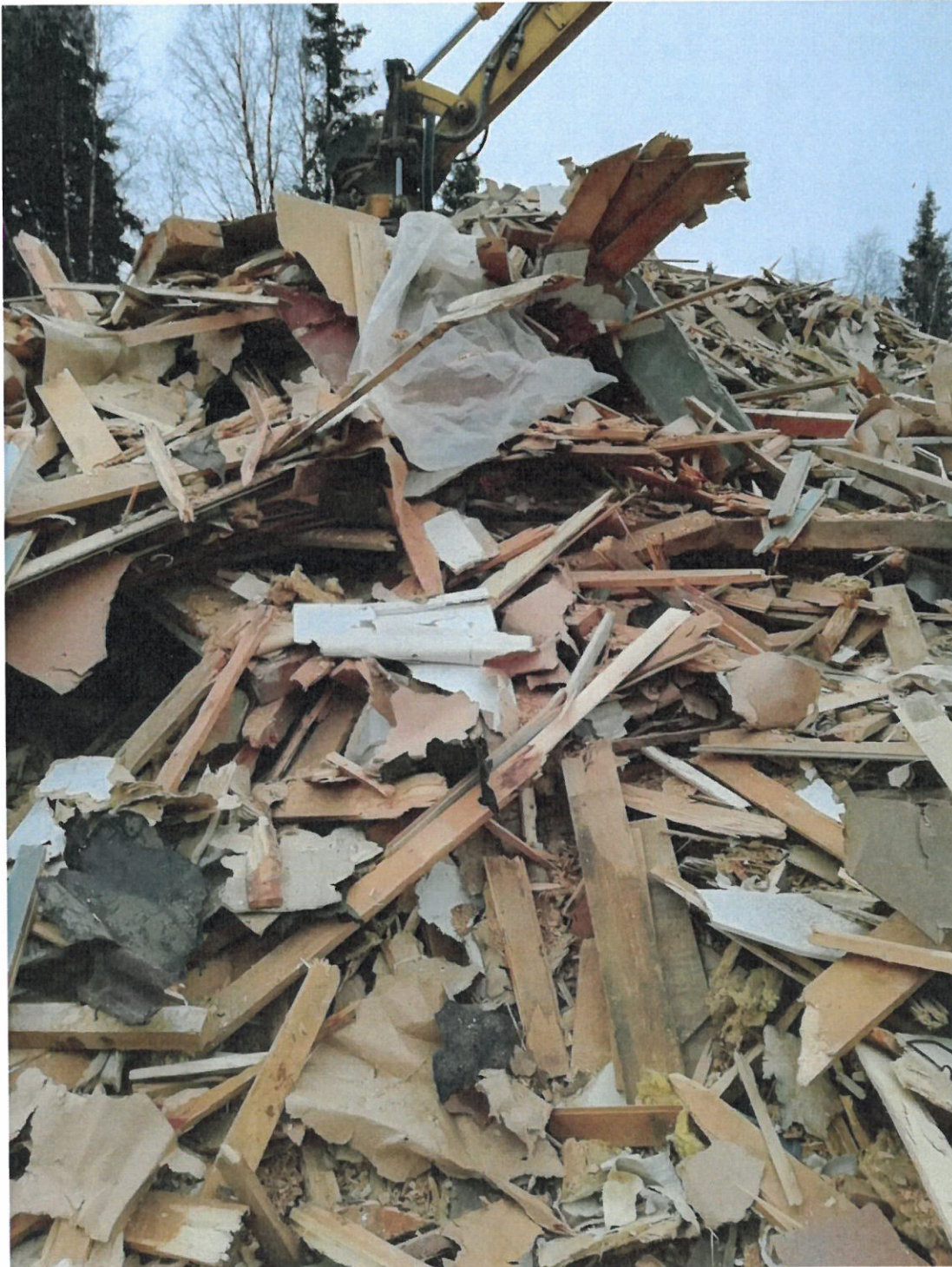
Kuva 8. Purkujätettä, joka on kuljetettu murskattavaksi kiinteistölle ROSKALA (583-402-27-5).
