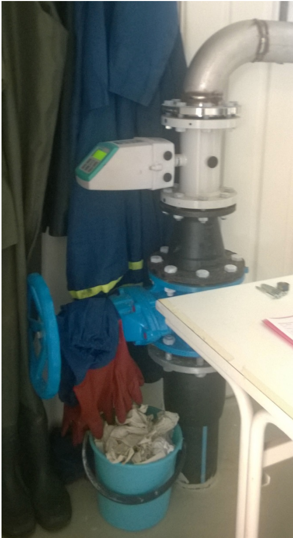
Vesimäärä mitataan jatkuvatoimisella magneettivirtausmittarilla Siemens DN100.
